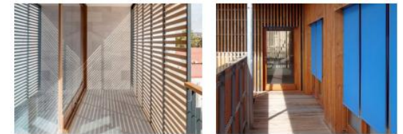
Exemples de protections solaires extérieures fixes et mobiles. Le balcon contribue également à protéger la façade. Logements "CP House" (Barcelone, Espagne), Alventosa Morell Arquitectes. Protection solaire extérieure, Groupe scolaire (Saint-Denis), Vincent Parreira AAVP.
