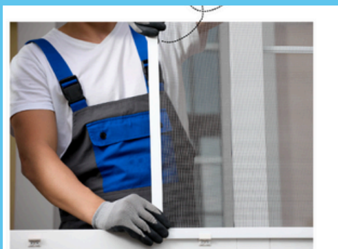
Pose de moustiquaires aux fenêtres
