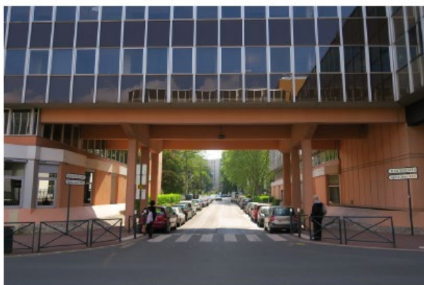
Bâtiment pont entre Grisons et Forez
