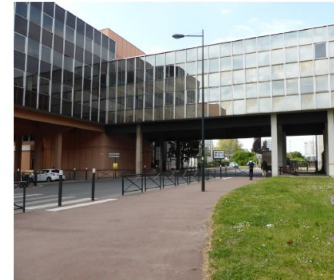
Angle bâtiment Forez : rencontre des bâtiments ponts
