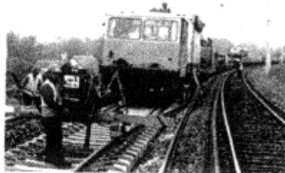
Longs Rails soudés sur traverses béton
