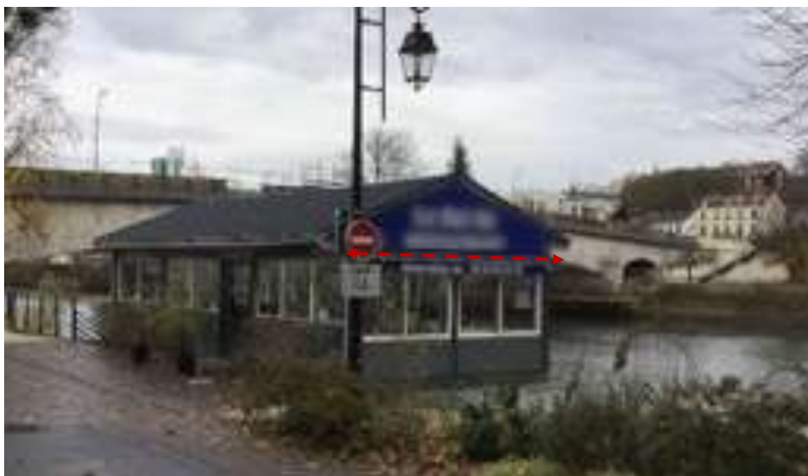
Enseigne parallèle dépassant les limites de l’égout du toit – Le Perreux-sur-Marne – 2019
