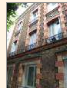
3 boulevard André Bassée : encadrements de baies harpés en briques bicolores.
