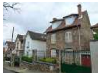
Diversité architecturale, mais cohérence du paysage urbain grâce aux clôtures.
