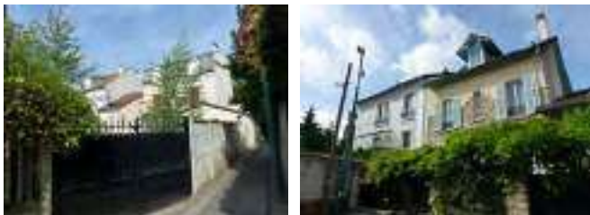
Villa Mémoris : Le caractère hétérogène des constructions et de leur implantation est nuancé par une cohérence dans les transitions entre les espaces privés et la voie : murs de clôtures et végétation privée qui déborde visuellement donnent sa cohérence à la villa.
