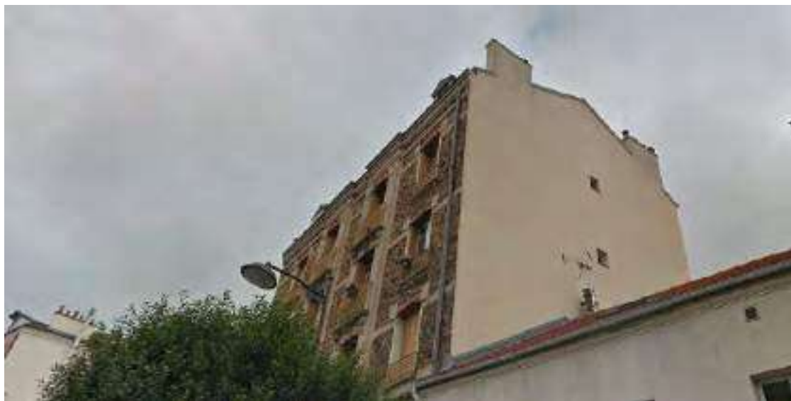
Vue d'un pignon d'un bâtiment meulière – Rue Mot
