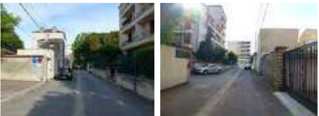
Villa Saint-Louis : une emprise privée déjà existante en 1874, mais qui souffre d'un manque de qualité des aménagements (réseaux) qui ne contribue pas à sa mise en valeur.
