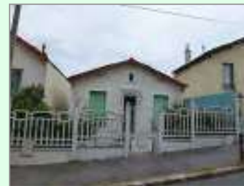
15 Rue d'Alger : ces clôtures bétons offrent une certaine qualité ; mais le savoir-faire de leur mode constructif s'est fréquemment perdu, posant la question du coût de leur entretien.
