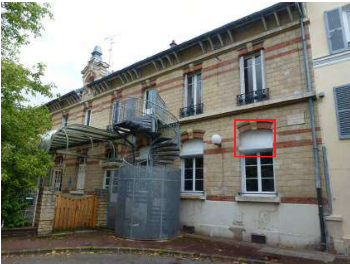
Vue sur la façade arrière, depuis le boulevard André Bassée.
