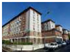
Rue Pasteur : ensemble remarquable
