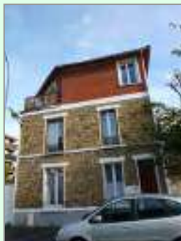
Rue Maison Rouge : une surélévation en rupture (volumes, matériaux) avec le style de la construction
