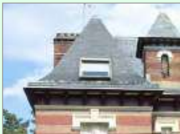
Avenue de la Belle Gabrielle : une fenêtre de toiture particulièrement visible depuis la voie publique.
