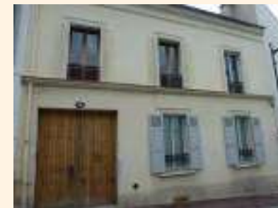
MENUISERIES : 20 Rue de Rosny : dégradation progressive des menuiseries. Le remplacement des menuiseries d'origine par des menuiseries bois entraîne dans un premier la disparition des petits bois (1er étage). Dans un second temps, remplacement des menuiseries bois par du PVC. A droite : 1 rue Grogard.
