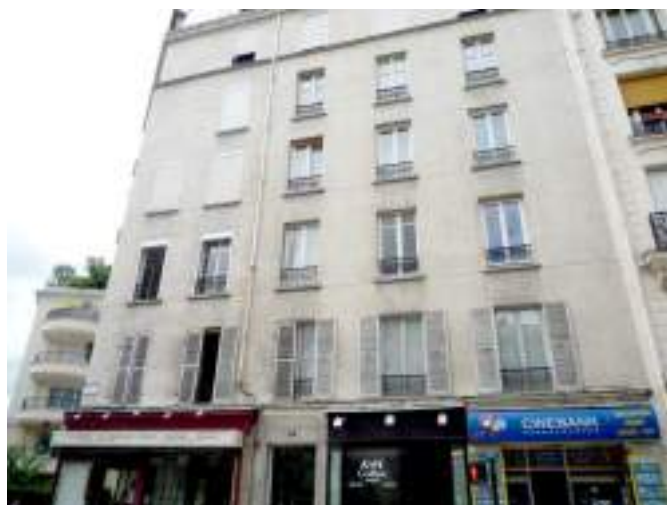
Disparition des persiennes, modification des menuiseries bois
