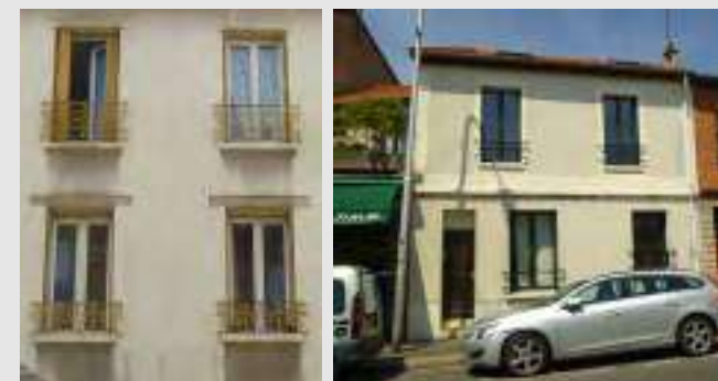
Exemple de façades pouvant faire l'objet d'une ITE : les appuis de baie devront être restitués, tout comme les traitements particuliers de l'enduit des trumeaux (immeuble de droite).
