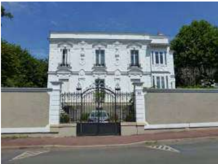
La villa et sa clôture constituent un ensemble cohérent.
