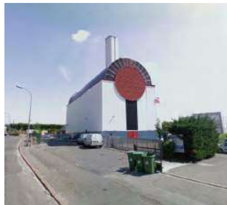
Chaufferie de la Régie du Chauffage Urbain
