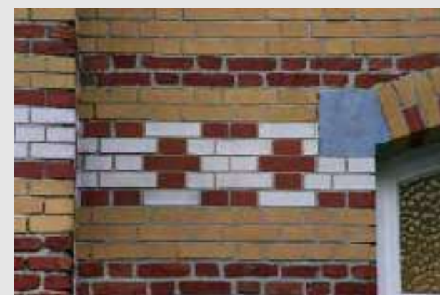
Parement avec appareil de briques polychromes
