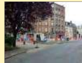
Le carrefour entre les rues Mauconseil, Dalayrac et du Commandant Jean Duhail : une ancienne entrée de village. Aujourd'hui une des portes d'entrée du bourg, en travaux au moment du diagnostic.
