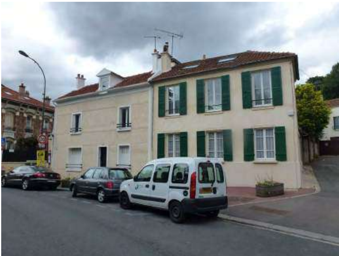
Les deux maisons de bourg se détachent nettement dans le paysage de la rue.
