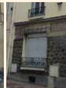
GARDES-CORPS - 19 Rue de l'Ancienne Mairie ; 13 rue de Rosny : remplacement des garde-corps par des appuis circulaires, très en vogue dans les années 1950.
