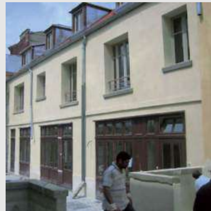
Ex. d'une opération neuve en centre ancien, reprenant le vocabulaire de l'architecture de bourg.
