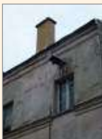
Détail de la façade arrière du 1 rue de Neuilly
