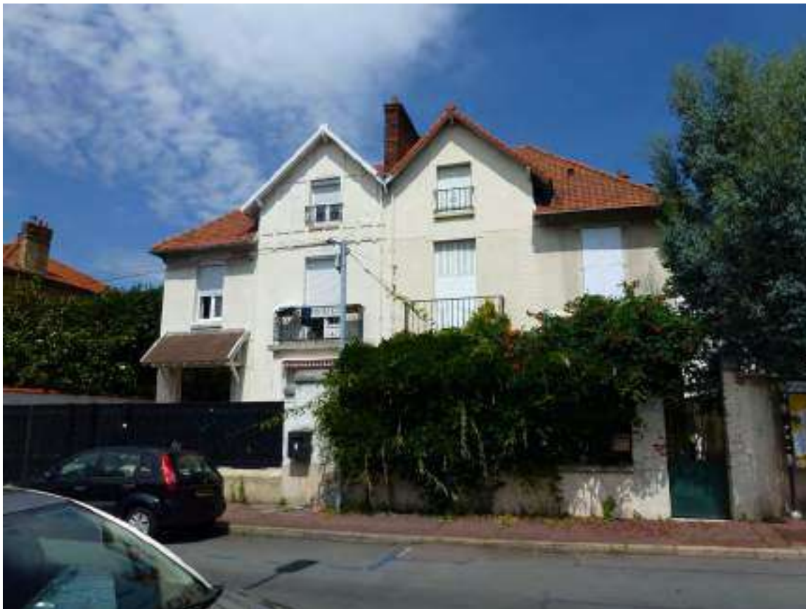
42 bis et 42 ter Avenue Foch
