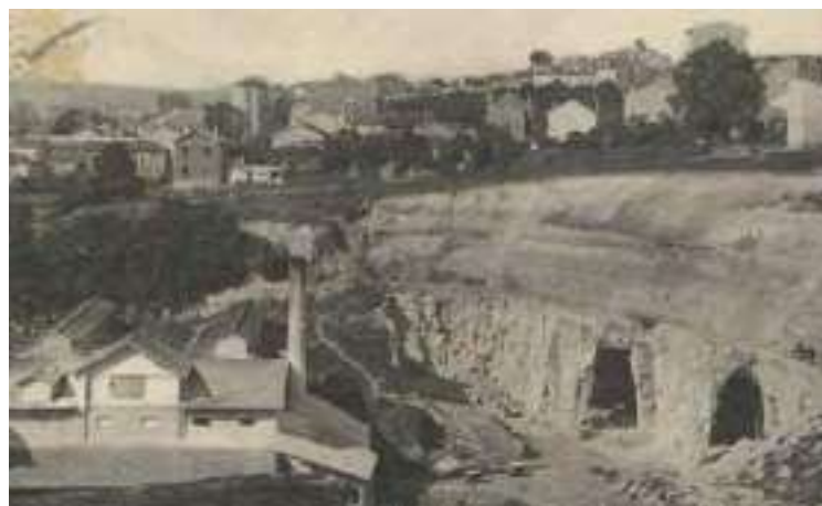
Ancienne carrière de Gypse de Fontenay-sous-Bois, l'entrée des galeries de première masse est visible
