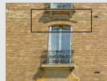
Exemple d'un linteau en arc segmentaire
