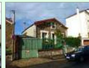
Rue Castel : la création d'un garage entraîne des modifications de la clôture
