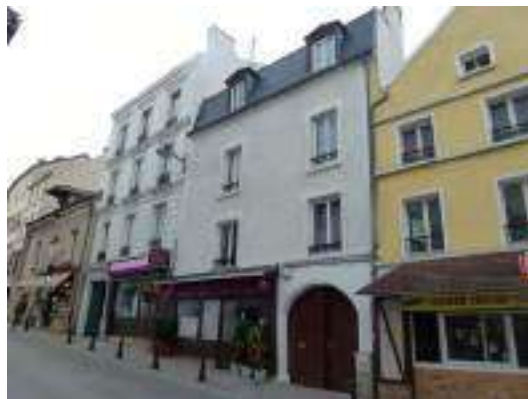
Plus au sud, au niveau de la place du Général Leclerc, les garbarits sont plus importants. L'ambiance est moins villageoise, plus urbaine.
