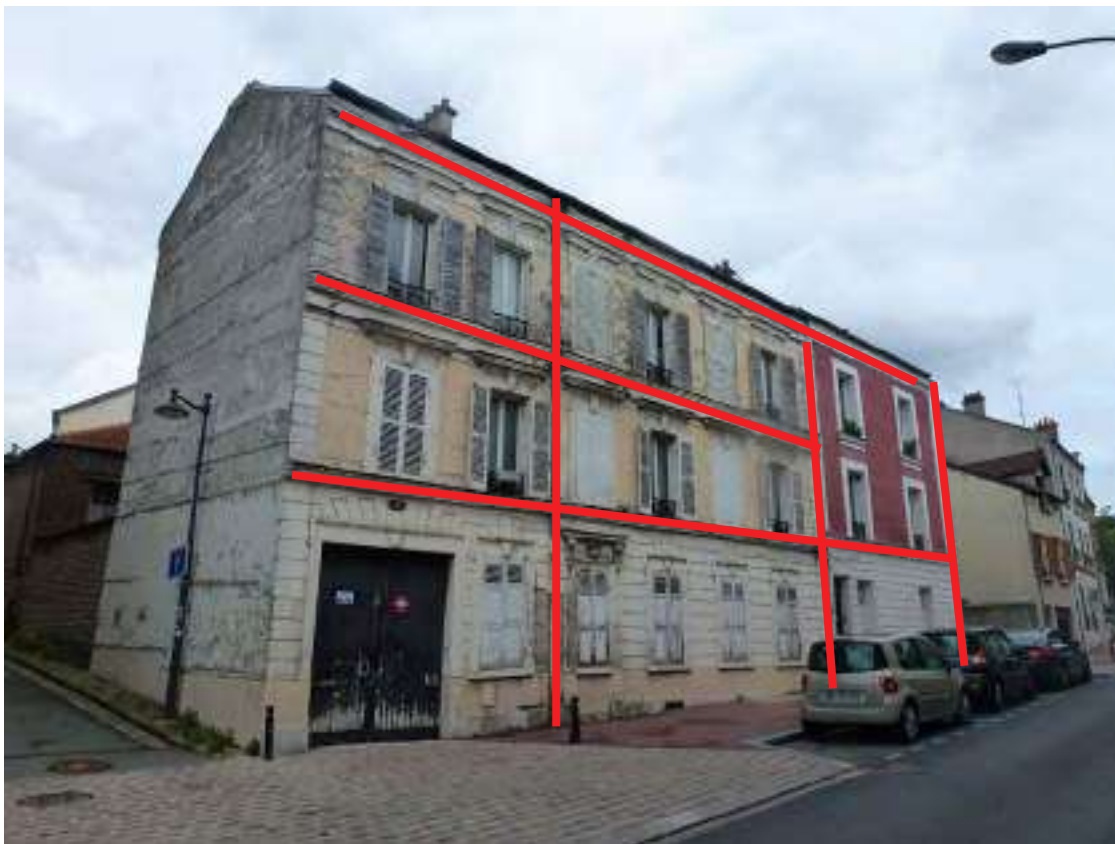
Les deux maisons de bourg se détachent nettement dans le paysage de la rue.
