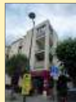
Construction moderne sur la frange nord du boulevard André Bassée
