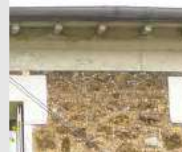
La richesse des parements de façade, des mises en œuvre de meulière, de brique, des décors... est à maintenir.
