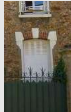
Persiennes métalliques repliables en tableau
