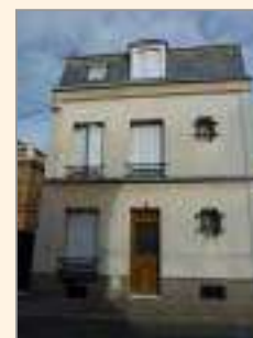
2 rue Pierre Sénard : une des rares toitures en mansarde de cette typologie.
