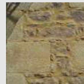
Joint à la chaux teinté d'ocre sur appareil de pierre
