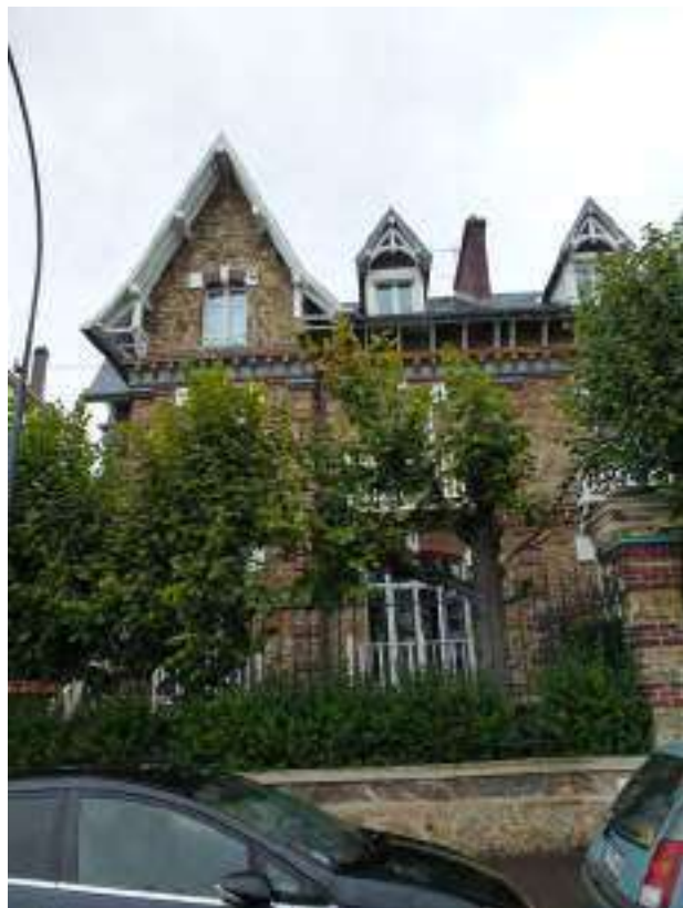
N°32 Bis Boulevard de Vincennes
