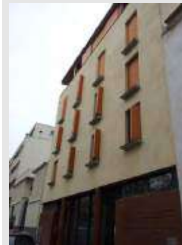
Volets bois repliables en tableau.
