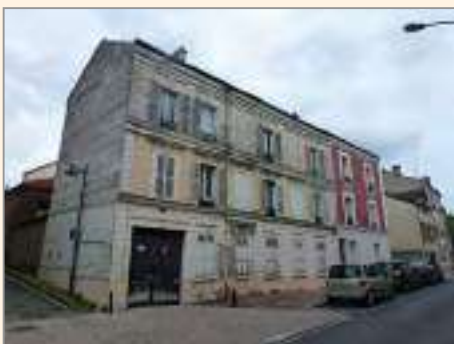
1 rue de Neuilly : soubassement en pierre apparente, importance de la continuité des bandeaux et corniches.
