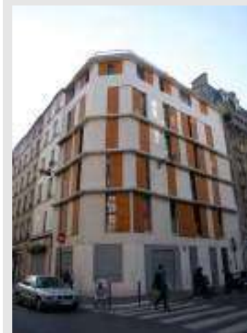
Volets bois sur rail.
