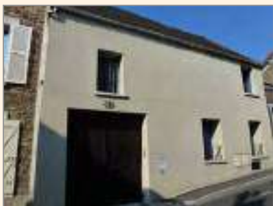
5 rue Saint-Germain, exemple de linteau enduit.
