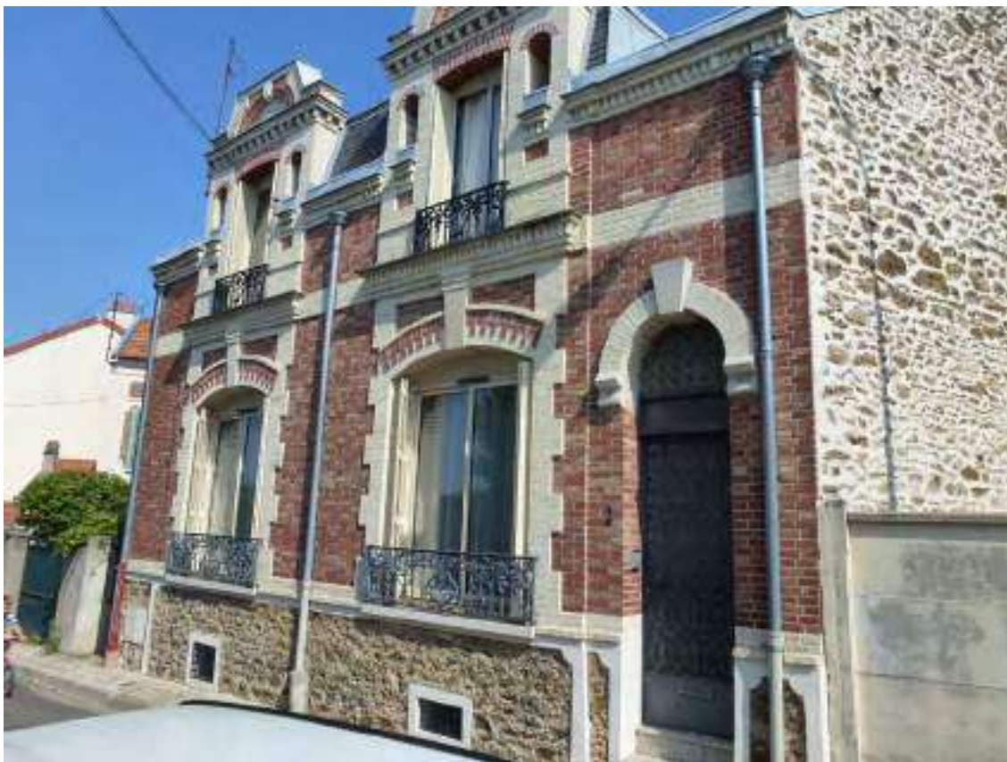
L'architecture de la villa la distingue du paysage de la rue.
