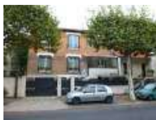
Au niveau du 13 bvd du 25 août 1944
