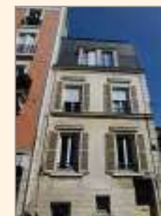
14 rue Grogard : toiture mansardée et soubassement en pierre apparente.
