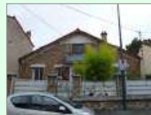
Rue Corneille : modification conséquente du volume d'origine.
