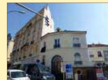
Toutefois, des ruptures architecturales subsistent dans le tissu urbain de la rue.
