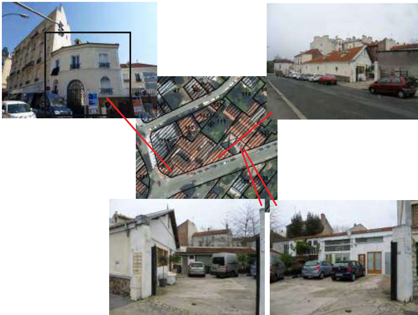
L'ancienne usine de jouets occupe une position stratégique, au niveau du croisement avec la rue Maurice Couderchet.
