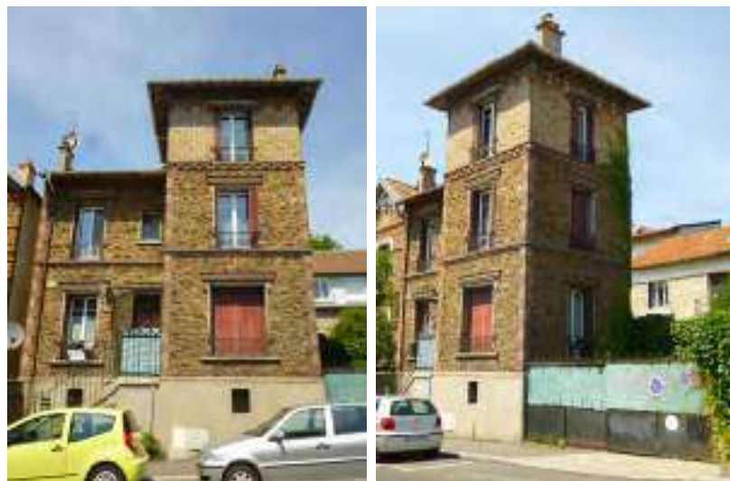
La position urbaine de la villa et le maintien d'une cour permettent une mise en scène de la façade.
