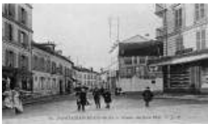
Place de Rue Mot
