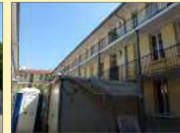
L'organisation du même immeuble, côté cour. Un passage sous porche débouche sur la rue de Neuilly.
