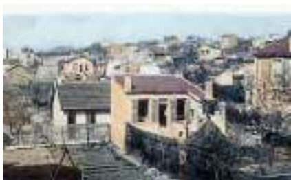
« Quartier du Peuple » - Parapluie
