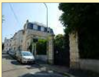
La rue Grognard, en place dès le 18e siècle, a considérablement évolué : un bâti 19e siècle s'y est implanté, mettant en scène une entrée monumentale qui apporte une respiration dans le paysage de la voie.
