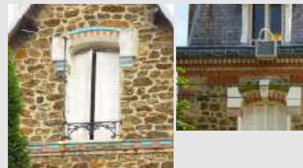
La richesse des parements de façade, des mises en œuvre de meulière, de brique, des décors... est à maintenir.
