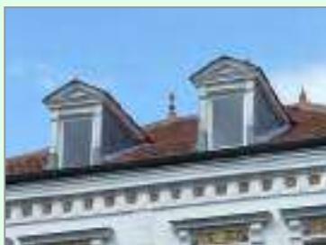
Avenue de la Dame Blanche : disparition de la partition d'origine des menuiseries
