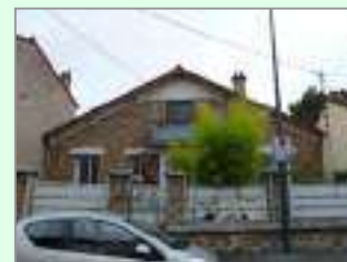
Rue Corneille : modification conséquente du volume d'origine.
