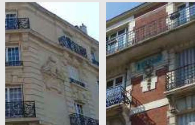
Existence de nombreux décors et modénatures qui limitent fortement les possibilités d'ITE.
