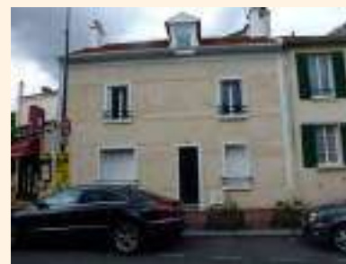
GARDES-CORPS - 19 Rue de l'Ancienne Mairie ; 13 rue de Rosny : remplacement des garde-corps par des appuis circulaires, très en vogue dans les années 1950.
