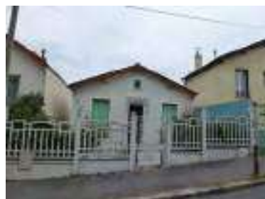
Pavillon-modèle préservé dans son volume d'origine et clôture béton - 15 rue d'Alger
