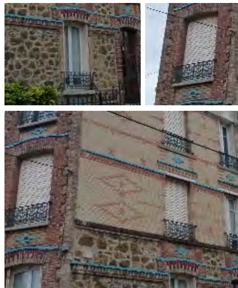
Détails de la façade et des modénatures.
