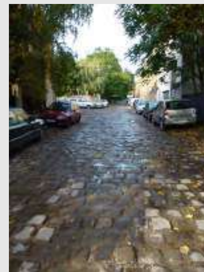
Villa des Carrières : un traitement de réseau viaire à améliorer pour permettre son accessibilité à tous.
