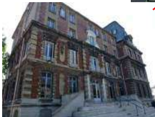
Vue de la façade arrière
