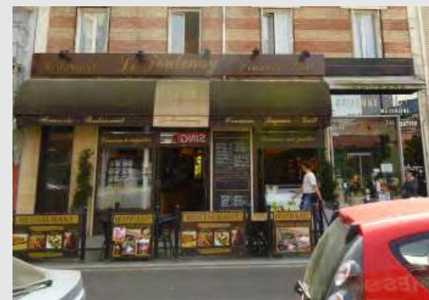
L'enseigne positionnée à mi-hauteur dans les étages vient gommer la lisibilité de la composition de la construction.
