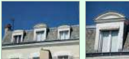
Rue du Clos d'Orléans : ouvertures en toiture.
