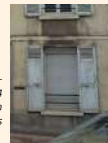
GARDES-CORPS - 19 Rue de l'Ancienne Mairie ; 13 rue de Rosny : remplacement des garde-corps par des appuis circulaires, très en vogue dans les années 1950.
