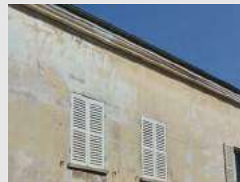
Traces de badigeon ancien : les façades des constructions de bourg pouvaient à l'origine comporter ce type de finition, créant une harmonie entre la coloration de la façade et la couleur des tuiles utilisées en couverture.
