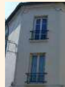
MENUISERIES : 20 Rue de Rosny : dégradation progressive des menuiseries. Le remplacement des menuiseries d'origine par des menuiseries bois entraîne dans un premier la disparition des petits bois (1er étage). Dans un second temps, remplacement des menuiseries bois par du PVC. A droite : 1 rue Grogard.
