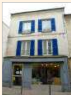
3 rue Mauconseil : des lignes simples, partiellement gommées par la baie vitrée de la devanture commerciale
