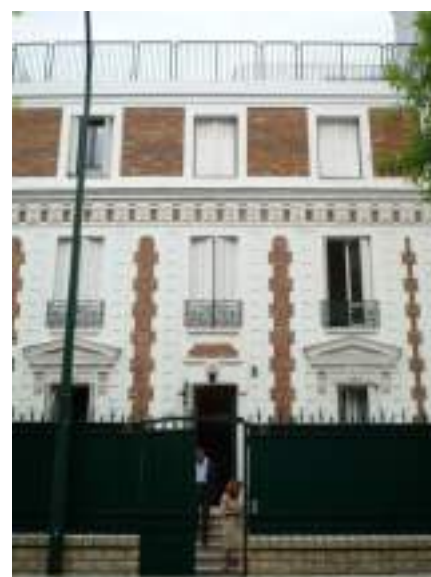
Disparition des persiennes, modification des menuiseries bois
