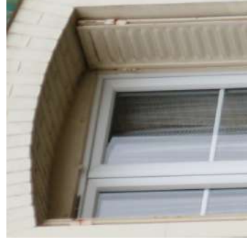
TRAVAUX INADAPTÉS : L'usage et la taille des petits carreaux doivent être cohérents avec l'époque et le style du bâtiment.
