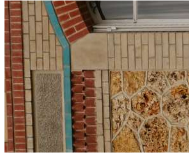
Façade polychrome av. Foch
