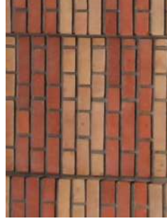
Parement de briques argileuses
