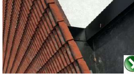
Bonne pratique : Détail de remontée d'étanchéité sous toiture existante
