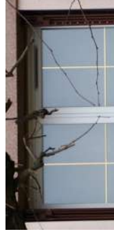
TRAVAUX INADAPTÉS : Pose d'une menuiserie rectangulaire dans une baie en arc surbaissé. Menuiserie plate en PVC blanc avec une baguette inter-vitrage. La menuiserie ne présente plus aucun relief.
