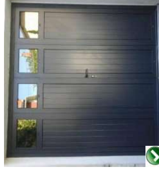
BONNE PRATIQUE : - portes en bois peint ou teinté ; - trame verticale ; - positionnement dans le tableau en retrait par rapport au nu du mur.
