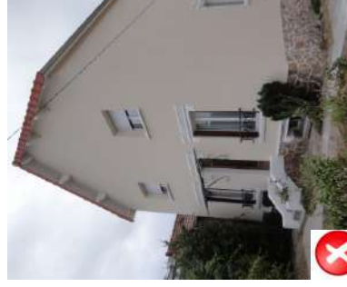
Mauvaise pratique : Mauvaise proportion des fenêtres ajoutées.
