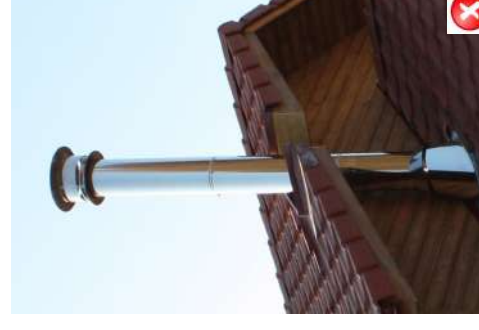
TRAVAUX INADAPTÉS : Positionner le conduit en bas de pente BONNE PRATIQUE : Positionner le conduit au plus près du faîtage pour limiter la hauteur de conduit
