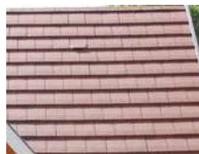
TUILES PLATES A EMBOITEMENT
