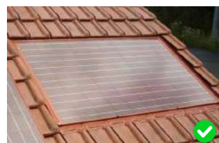
Pose intégrée dans le plan de couverture sans saillie et en harmonie avec la couleur de la couverture
