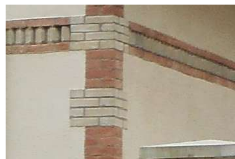
Chaînage d'angle en briques
