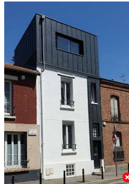
Changement de matérialité dans le prolongement du nu de façade (décoché préférable)
