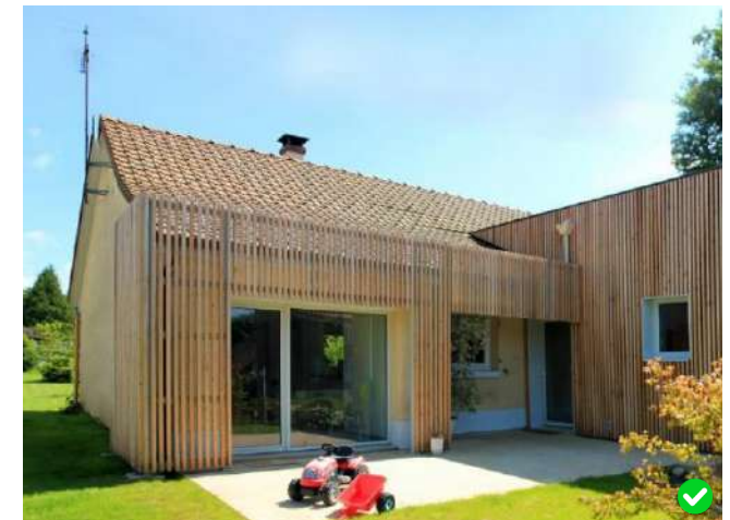
Ajout d'un nouveau matériau bois clair pour l'extension s'harmonisant avec les teintes beige/sable du pavillon existant.
