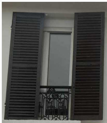
Volets battants persiennés à lames bois à la française
