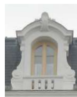
lucarne-fronton (ici, à ailerons et toit bombé)
