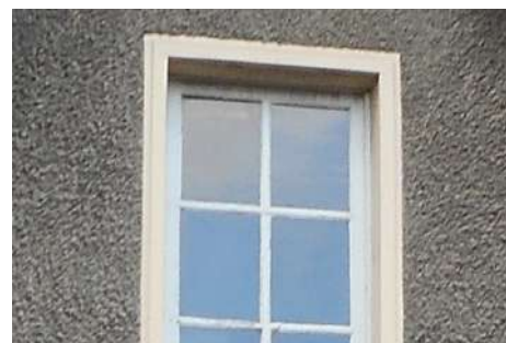
Encadrement de baie
