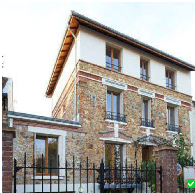
Matériaux, teintes et modénatures de la surélévation réinventent de façon contemporaine la typologie de la maison de l'entre-deux-guerres.
