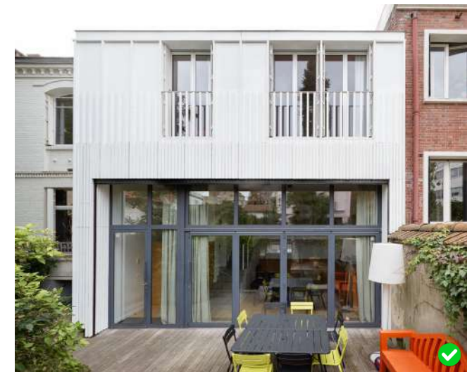
Reprise de la teinte claire en façade de l'extension, rappel des nuances des constructions voisines. Traitement contemporain des modénatures.
