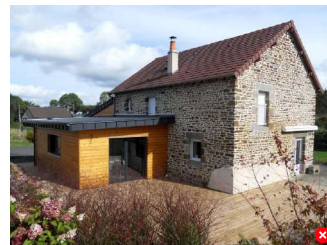
Bois jaune et couverture sombre sans cohérence de teinte et de matérialité avec le bâtiment d'origine.
