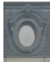
lucarne dite «œil-de-boeuf» en zinc façonné
