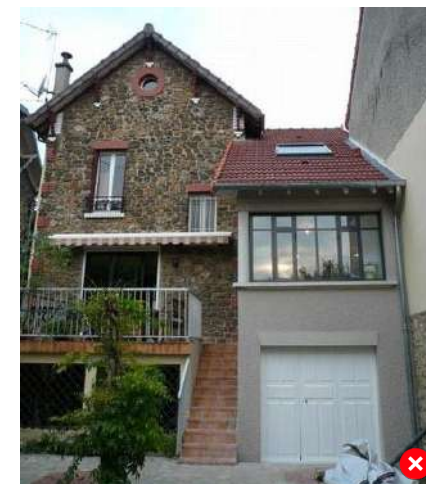
Différence de tonalités d'enduit et de couleurs entre les menuiseries de l'existant et de l'extension.
