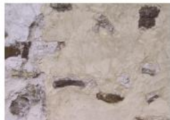
Enduit de plâtre, à "pierre vue", ocré
