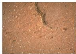
Enduit de chaux teinté dans la masse, ocre rouge
