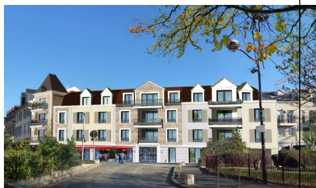
Opération 1-3 rue des Belles Vues
