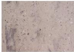
Enduit de chaux uniforme gratté fin
