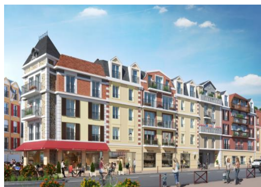
Opération rue la Fontaine / Boulevard de Mulhouse
