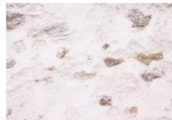
Enduit de plâtre à "pierre vue"
