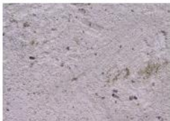
Enduit de plâtre uniforme gratté fin : plâtre gros, un peu de chaux aérienne, sable et charbon de bois
