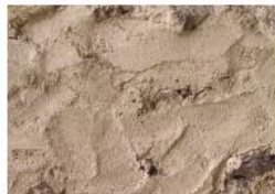
Enduit de chaux à "pierre vue", dégrossi avant finition
