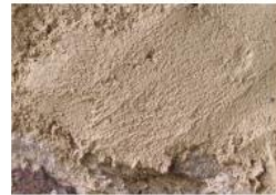
Serré et "gratté fin" ou lissé, l'enduit recouvre entièrement les pierres d'une couche de quelques centimètres
