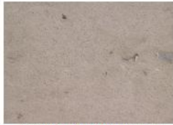
Enduit de chaux uniforme lissé ; chaux aérienne, sable de rivière et pigment ocre et terre de Sienne
