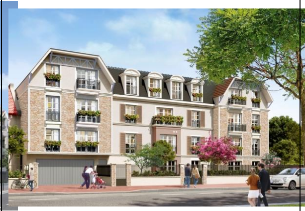
Opération 29 rue du Général Leclerc
