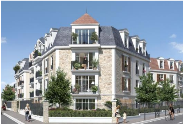
Opération à l'angle des rue de Chennevières / Docteur Bring
