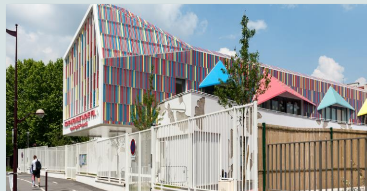
Le récent groupe scolaire S. Veil, issu du PRU des Hautes-Noues à Villiers-sur-Marne, permet de corriger en partie le déficit structurel d'équipements publics sur ce quartier.
