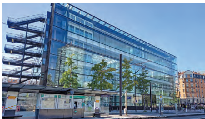
EPT 3 - ParisSanté Campus portant sur la e-santé, inauguré en décembre 2021 dans un bâtiment de 20 000 m 2 (Issy-les-Moulineaux).
