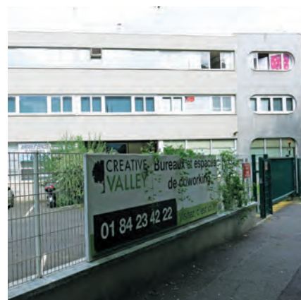
EPT 12 - Créative Valley, incubateur créé en 2011 (1 500 m 2 ) avec les écoles d'ingénieurs, opère un réseau de lieux d'appui (ADN, à Station F, structures de collectivités) (Le Kremlin-Bicêtre).
