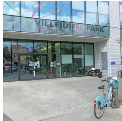
EPT 12 - Villejuif Bio Park, incubateur du réseau Wacano, de 7 500 m 2 créé en 2011, réalisé en lien avec Cancer Campus et l'Institut Gustave Roussy, entreprises de la santé et biotechs (Villejuif).
