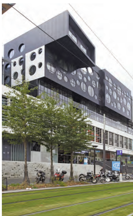
Le Cargo, hôtel d'entreprises RIVP (15 000 m 2 ), qui héberge sur 2 200 m 2 2 plateformes de Paris&Co : LINCC et Welcome City Lab (Paris, 19 e )
