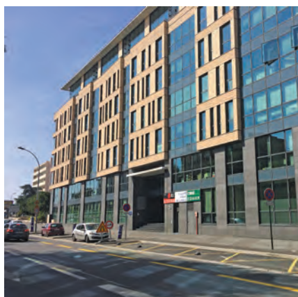
EPT 11 - Stop & Work - Regus, installé au 6 e étage d'un immeuble de bureau (Alfortville).
