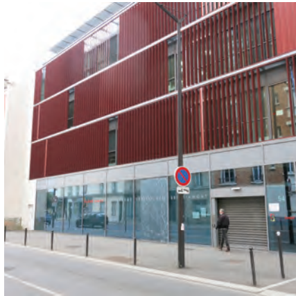
EPT 12 - Silver Innov, pépinière et hôtel d'entreprises de la Silver économie, ouverte en 2014 par l'EPT en lien avec Futurâge - Pôle Charles Foix (4 500 m 2 ). Héberge Silver Valley, FutuÂge, Autonom'innov (Ivry-sur-Seine).
