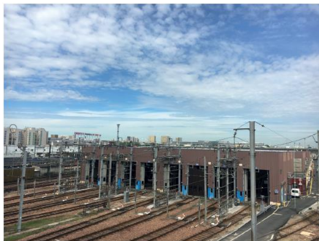
Atelier matériel Paris Sud Est depuis la passerelle Valmy
