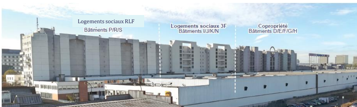
Façade nord de l'ensemble de logements, vue depuis l'actuelle passerelle de Valmy. En limite de propriété des entrepôts Escoffier.
